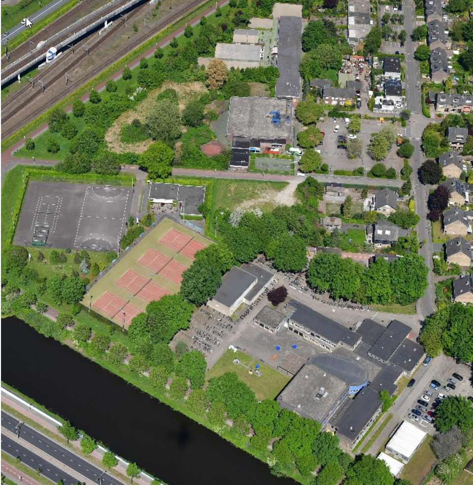
Vogelvluchtfoto bestaande situatie (voor sloop zwembad)
