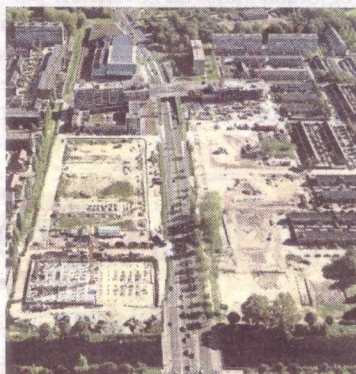
▲ Het Hogekwartier: één van de groeilocaties voor sociale woningbouw. FOTO AD
