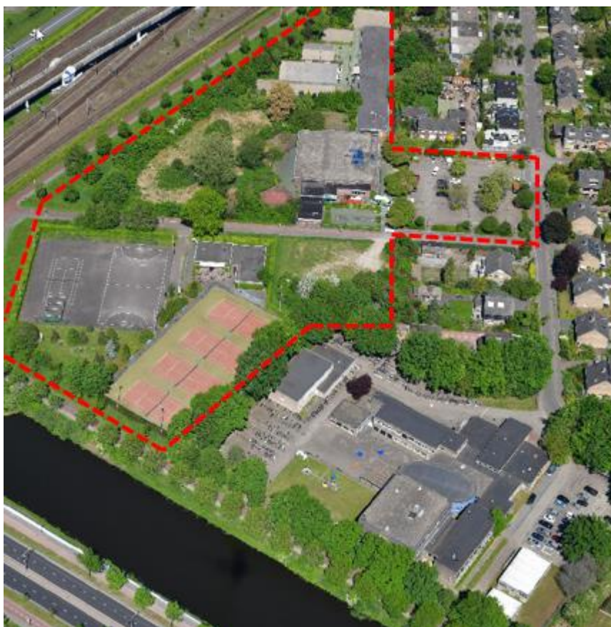
Vogelvluchtfoto bestaande situatie (voor sloop zwembad)
